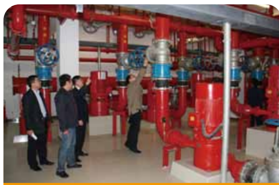
北京剧院管理公司管理中心检查组开展巡检工作
