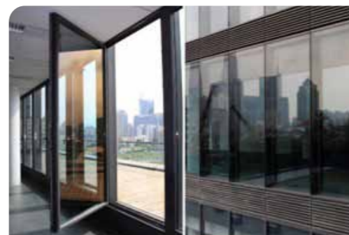
上海保利广场采用内通风双层呼吸式幕墙、高效节能电机机组等绿色建筑技术
