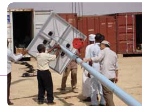
太阳能路灯安装
