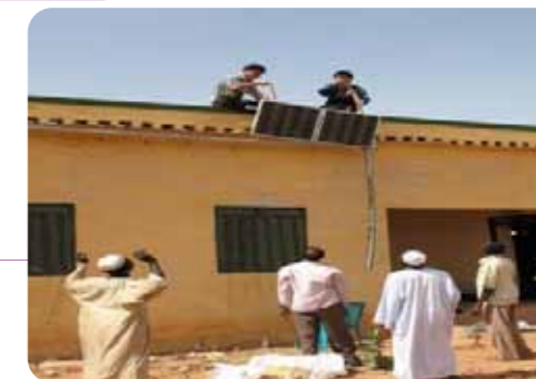
女子中学光伏供电系统安装
